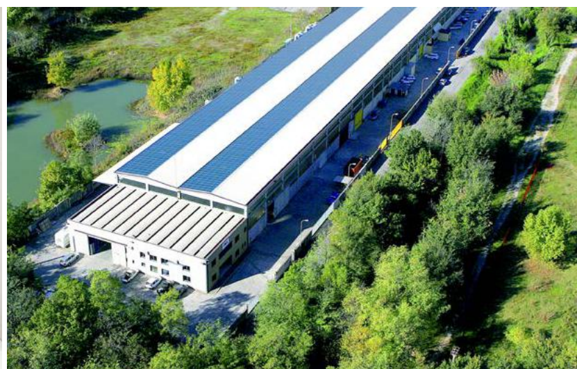
Lo stabilimento di Maicopresse S.p.A., sorge su 15.000 mq in prossimità dell'area urbana Bresciana, contigualmente allo stabilimento della consociata Irobi S.r.l.
