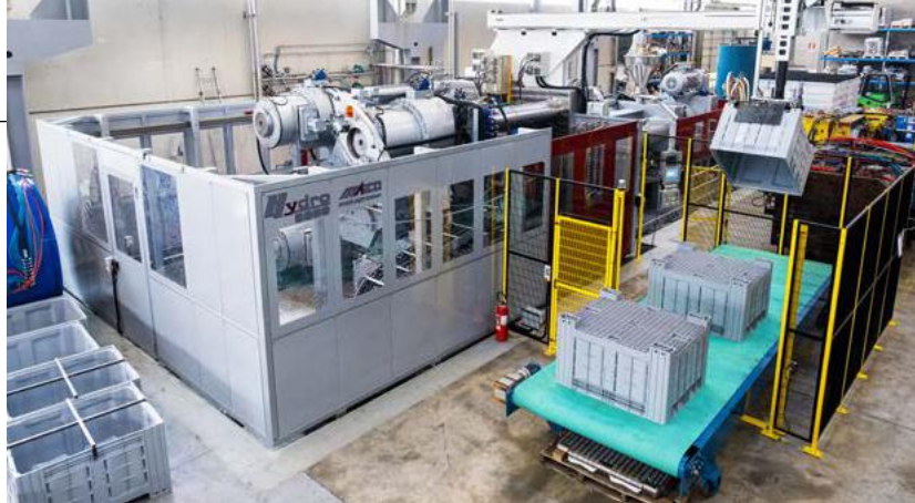
Hydro 5000 installata ed operativa presso lo stabilimento Project For Building (Mornico Al Serio / BG), dotata di robot Irobi per l'estrazione e la manipolazione del pezzo
